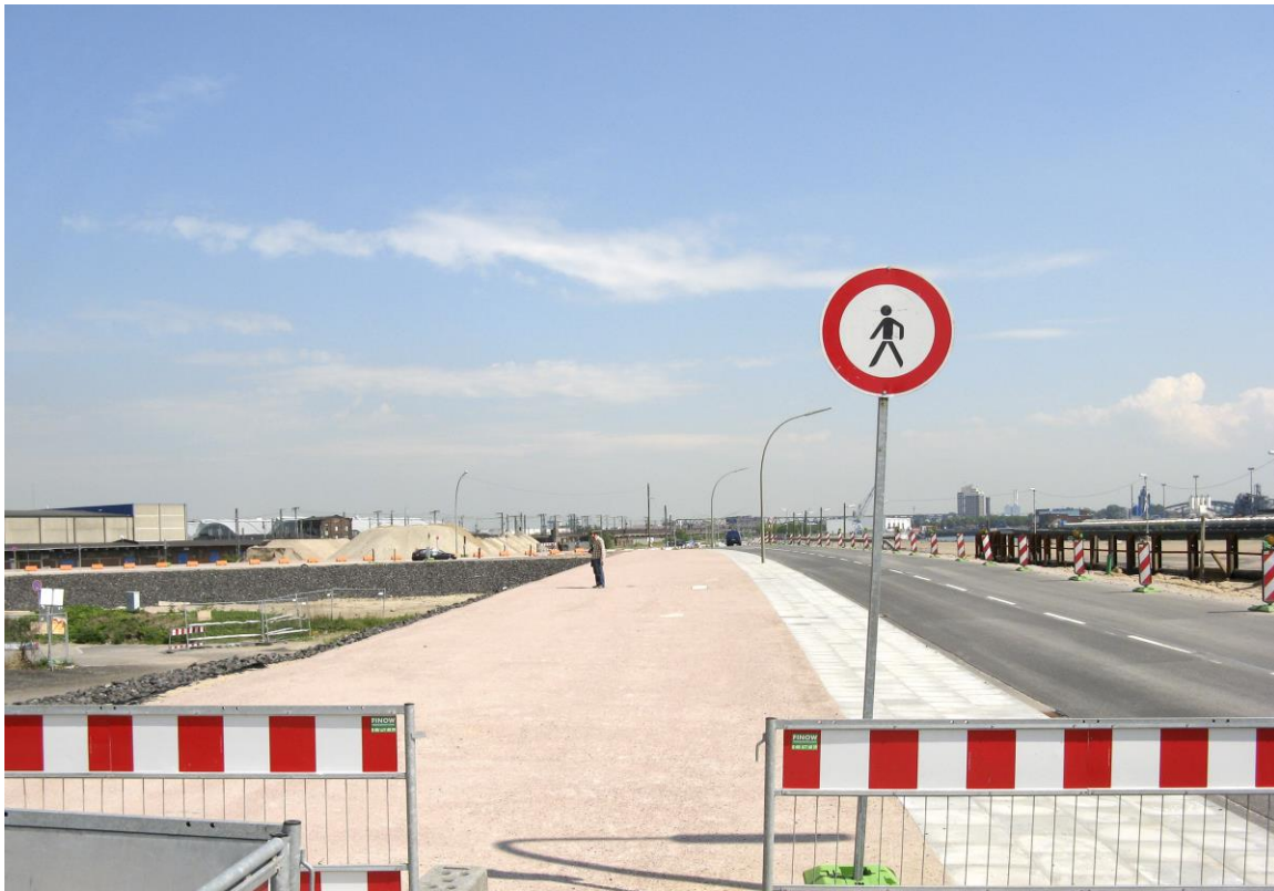
Hafencity, Baustelle 2013 (Foto: Matthias Krüttgen)
